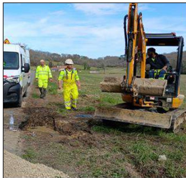
PECORADE - Réparation d'une fuite sur une ventouse route d'Aire
