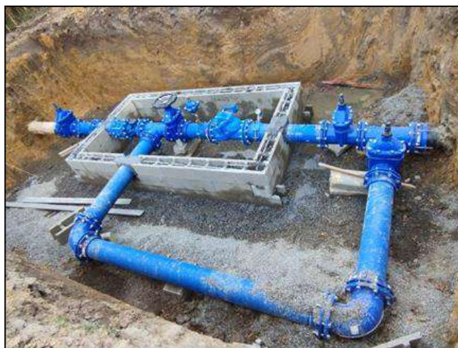
5 - Regard comptage + clapet AR Philondenx
