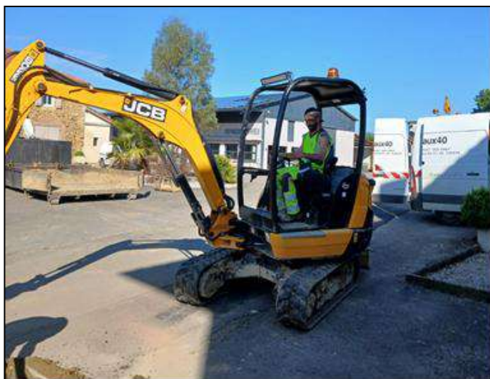
BAHUS-SOUBIRAN – Réalisation d'un branchement neuf d'eau potable chemin de Lassube
