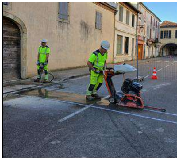
GEAUNE – Réalisation d'un branchement neuf d'eau potable rue Gourgues
