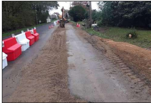
Chantier Cauna, avenue de Tartas : renouvellement canalisation AC
