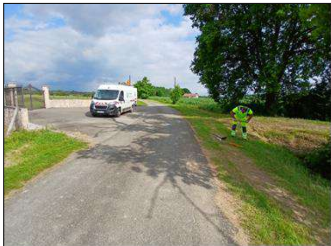
DUHORT-BACHEN Préparation chantier pour création Compteur de Sectorisation entre Duhort-Bachen et Renung
