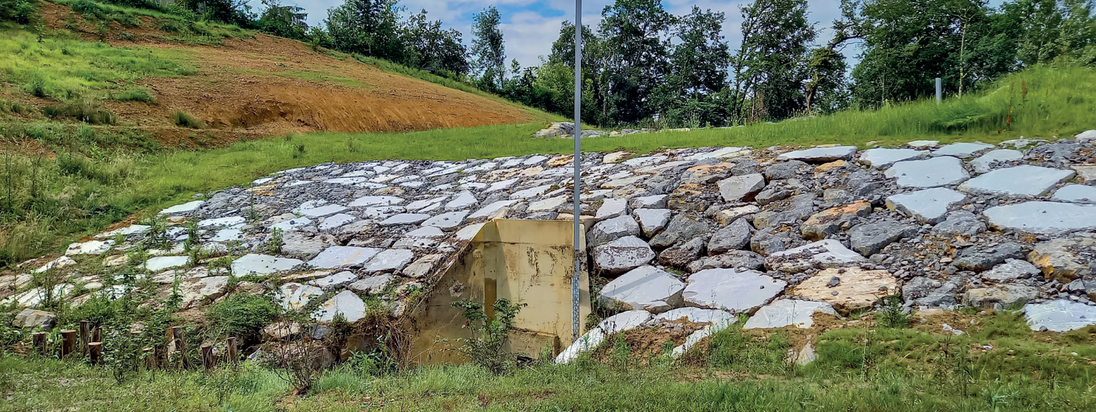
Barrage écrêteur de crue du Labarthe.
