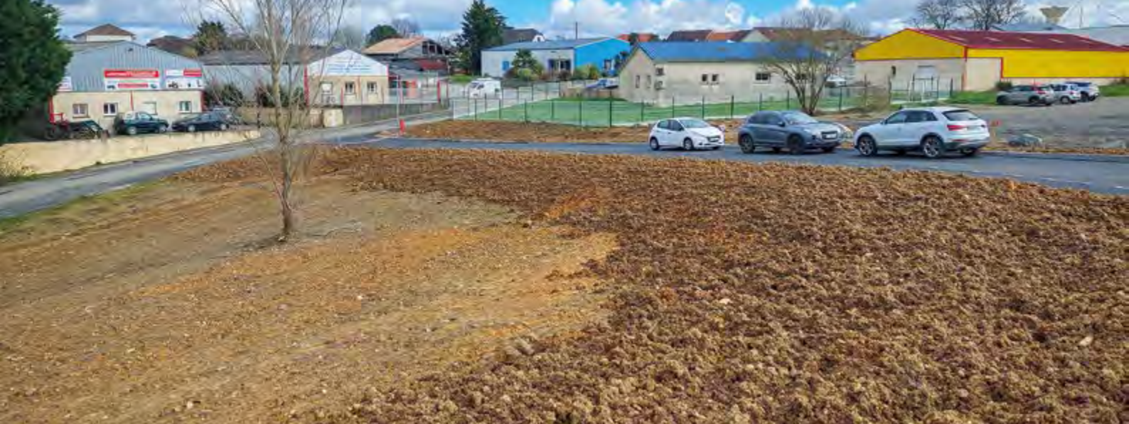
Aménagement du lotissement d'activités Arzacq 2
