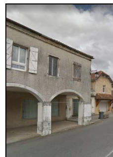
Exemple de construction vacante à Arzacq-Arraziguet
