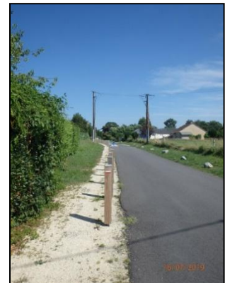
Aménagement piéton sécurisé à Poms
